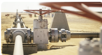
Uso industrial , como agua de refrigeración y agua de procesos en la industria petroquímica, de pulpa y papel, acero y textil.
