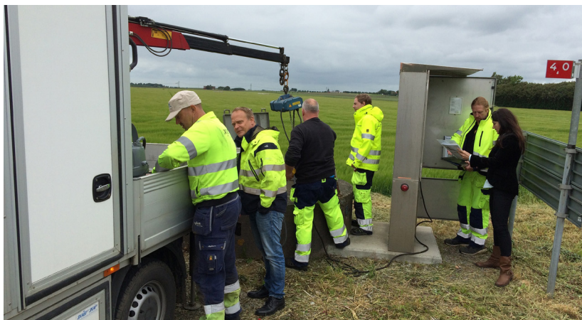
Installazione di Flygt Concertor nel Comune di Lomma.
