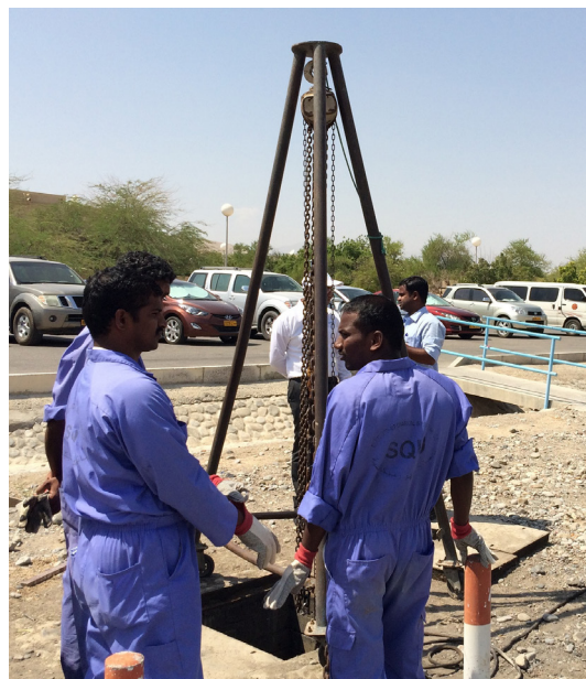
Operatori al lavoro durante l'installazione di Flygt Concertor presso un residence studenti della Sultan Qaboos University.
