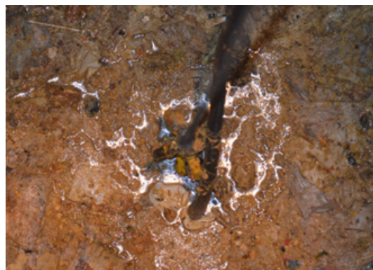
Innan de installerade Flygt Concertor hade Hallunda Gårdsväg 106A stora problem med avlagringar av fetter och olja.
