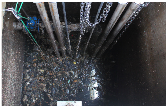
Til venstre en pumpepumpe i et av våre feltforsøk før Flygt Concertor™-systemet ble installert, og deretter etter to ukers drift (til høyre).
