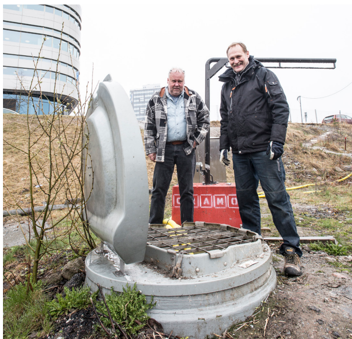
Anders Nyström, Xylem och Stefan Tenglund, Stockholm Vatten, inspekterar pumpstationen i Kista
