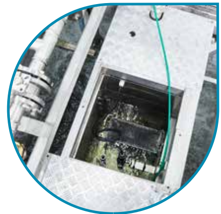
Der Taron-Belebtschlammfilter erzeugt Filtrat mit einer Feststoffkonzentration von weniger als 10 mg/L.
