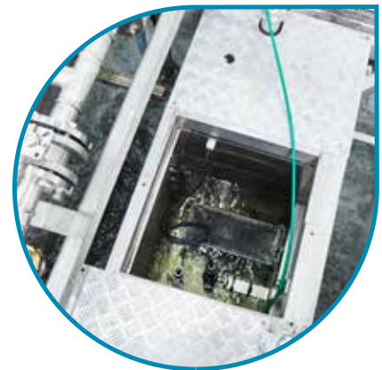
El filtro Taron puede producir efluentes de alta calidad con SST inferiores a 10 mg/L.
