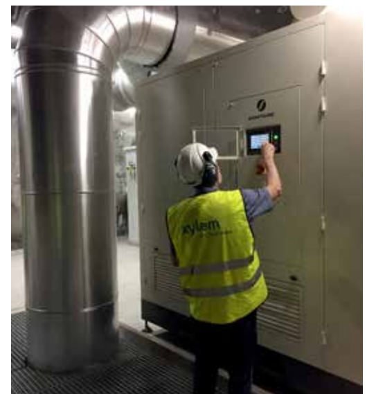
Xylem Mitarbeiter bei der Inbetriebnahme des MAX600-Gebläses (400 kW).
