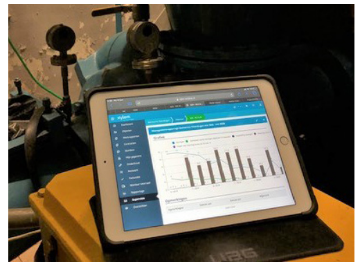
Onderhoud aan een gemaal in Vlaardingen, met behulp van data in XDM gepland en uitgevoerd.
