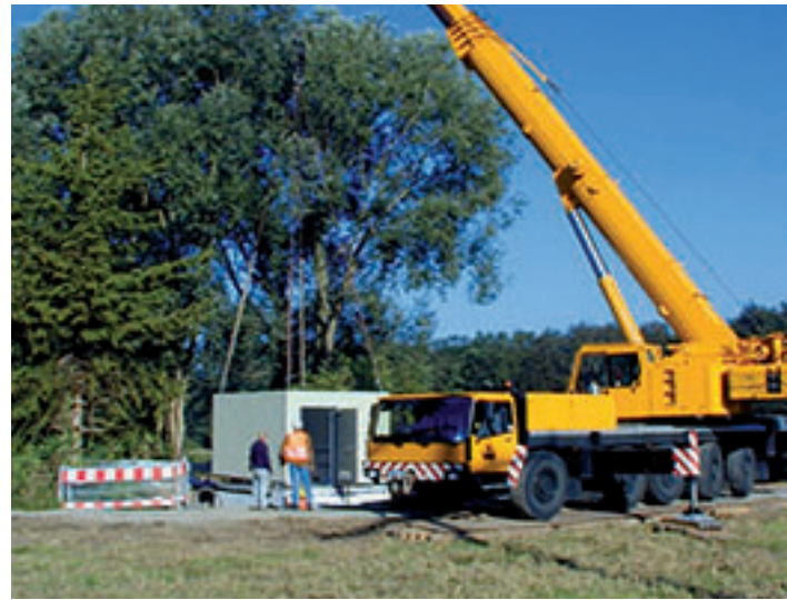
Einfache und schnelle Installation einer Kompaktpumpstation.
