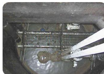
6 veckor efter slamsugning och installation av APF.
