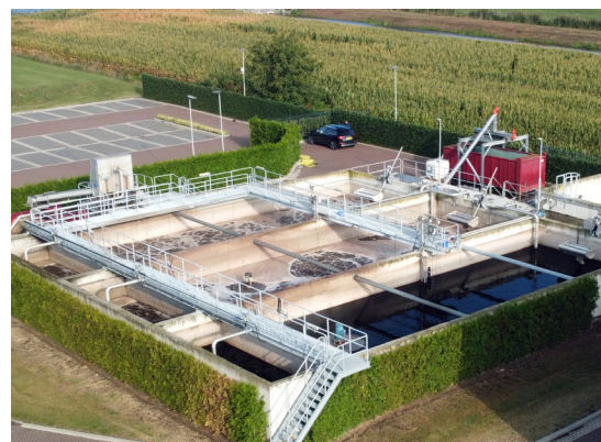
Prochamp's duurzame zuiveringsinstallatie met SBR-technologie
