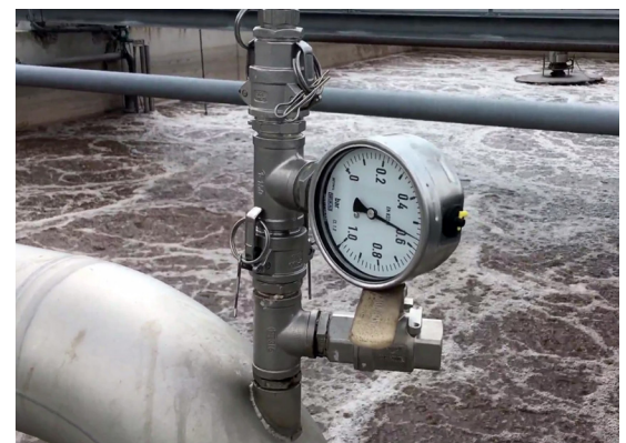
Direct resultaat met tegendruk verlaging tot 40 mBar per reinigingscyclus
