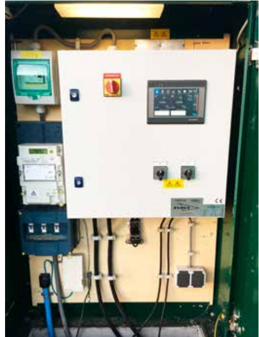
Een aangepaste schakelkast bij een gemaal in Sluis, voor het optimaliseren van het afvalwatertransport.
