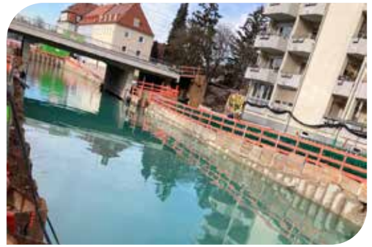
Einsatzort Grundwasserwanne München-Moosach
